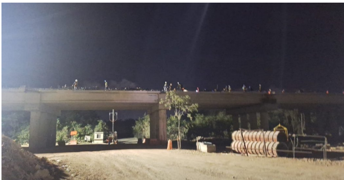
Trabajos nocturnos en el viaducto elevado.
