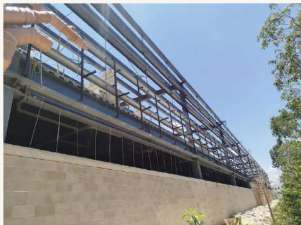
04 • Montaje de estructura metálica y cubiertas
